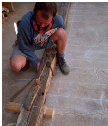
Le charpentier contrôle la ligne de niveau sur la pièce de bois mise sur épure, par une plumée de dévers.
