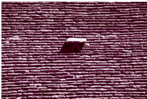
Il existe dans le bâti ancien toute une hiérarchie d'ouvertures de toit. Les plus simples, comme ici, servent à la seule aération des combles.
