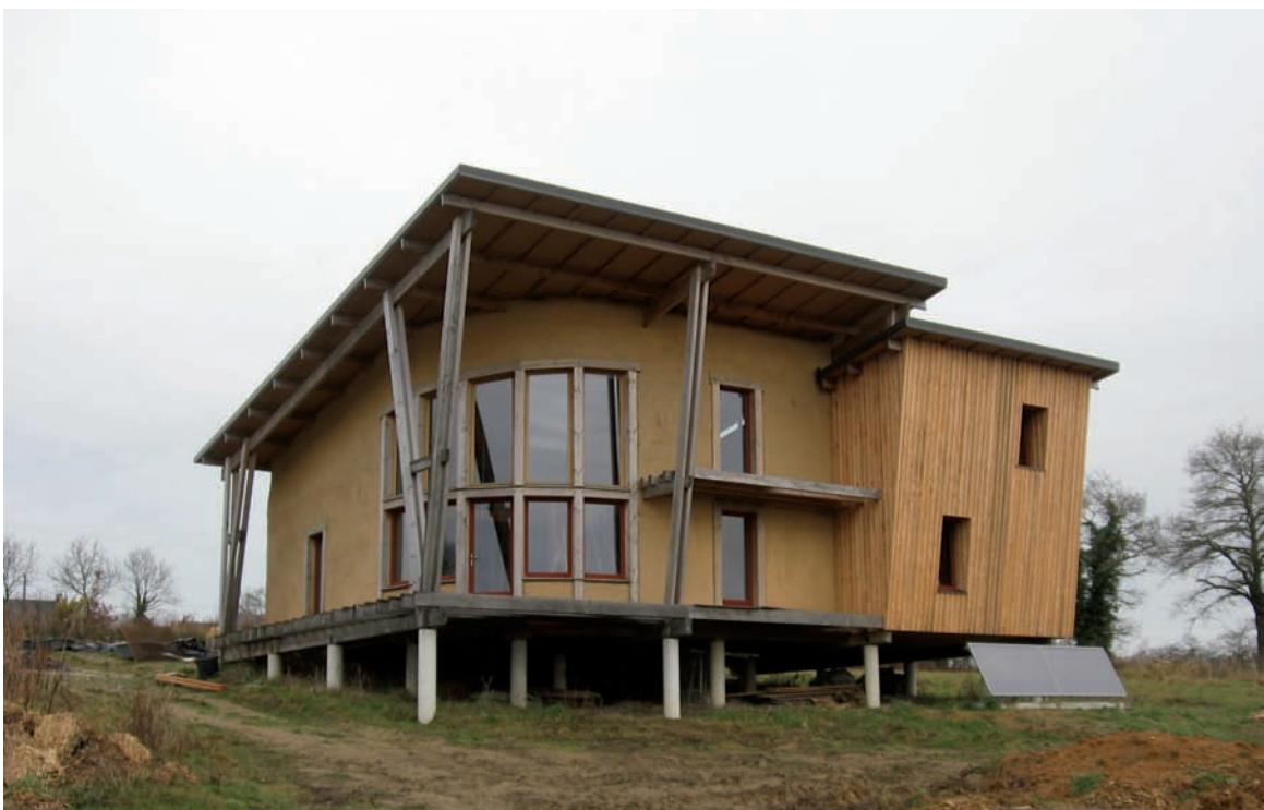
Pour couler ces poteaux de béton, on peut utiliser des moules circulaires (en vente chez les fournisseurs de matériaux), après y avoir introduit ce qu'il faut de « ferraille » pour armer le béton. Il y a une cave qui, au cours des travaux, s'est remplie d'eau entrée... par les gaines électriques. On y a remédié en perçant celles-ci avant qu'elles pénètrent le mur. L'arrondi autour de la grande baie a été réalisé en bottes de paille (90 cm x 45 cm x 35 cm, posées à plat), recouvertes de 3 couches de terre : une couche d'argile de rebouchage (une « barbotine » très liquide de 0,5 cm d'épaisseur) ; une couche de corps d'enduit (terre + paille + copeaux + sable) ; une couche de finition (barbotine épaisse, avec moins de terre et plus de sable que les précédentes).
