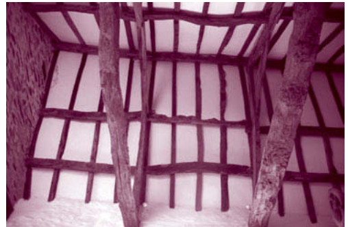
L'isolation du toit par l'extérieur, retenue ici, met en valeur la totalité de la charpente.
