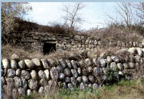
Muret de soutènement en galets – dont certains «parementés» à coups de marteau – empilés verticalement sur leur « côté » le plus étroit. (Les Vans, Ardèche.)
