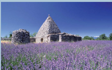
Ensemble constitué par une cabane et son mur pare-vent, un appentis (autrefois en tuiles canal) et un puits couvert. La cabane est surmontée d'une pyramide aux faces curvilignes et aux angles arrondis. (Saignon, Vaucluse.)
