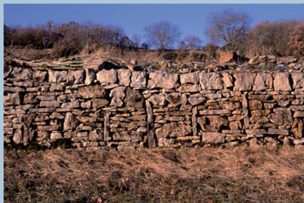
Muret de soutènement incurvé longitudinalement et comportant une armature de pierres posées «en demoiselle» sous un couronnement de blocs de pression. (Comprégnac, Aveyron.)
