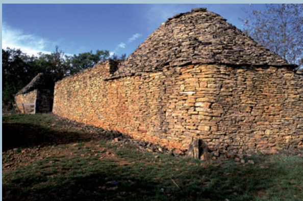
Ensemble constitué par une cabane et son mur pare-vent, un appentis (autrefois en tuiles canal) et un puits couvert. La cabane est surmontée d'une pyramide aux faces curvilignes et aux angles arrondis. (Saignon, Vaucluse.)
