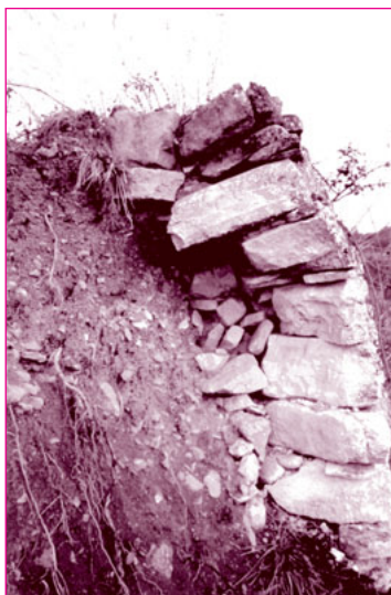
Brèche donnant la coupe d'un mur de soutènement en grès : de droite à gauche, le parement du mur formé de boutisses, le drain constitué de pierraille, la terre mêlée de cailloux ou d'esquilles.
